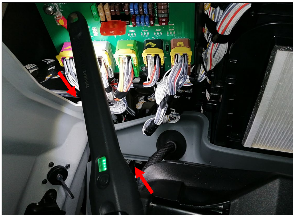
Spina per il pressacavo: vista dall'interno della cabina dietro a destra
